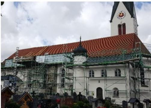
Diese Bauarbeiten sind nötig, da das Bistum Augsburg in den vergangenen Jahren sämtliche Pfarrkirchen einer Standsicherheitsüberprüfung unterzogen hat. Dabei wurde festgestellt, dass diese in St. Verena nicht dauerhaft gesichert ist.
