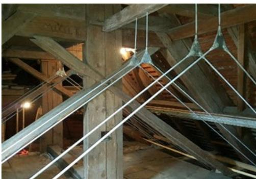
wurden die Außenmauern und somit die Gewölbedecke damals gesichert. Allerdings halten die mittlerweile 150 Jahre alten Stützpfäiler die Bewegung im Mauerwerk nicht dauerhaft aus. Deshalb wurde bei den diesjährigen Bauarbeiten im Dachstuhl mit Stahlseilen eine Absicherung der Gewölbedecke und der Außenmauern errichtet. Außerdem wurden Schäden am Dachstuhl behoben und die Firstziegel wurden erneuert.
